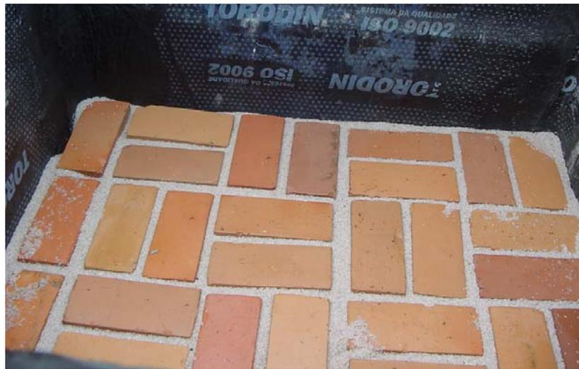
Fotografia 15 - Leito de secagem após a colocação do meio filtrante
