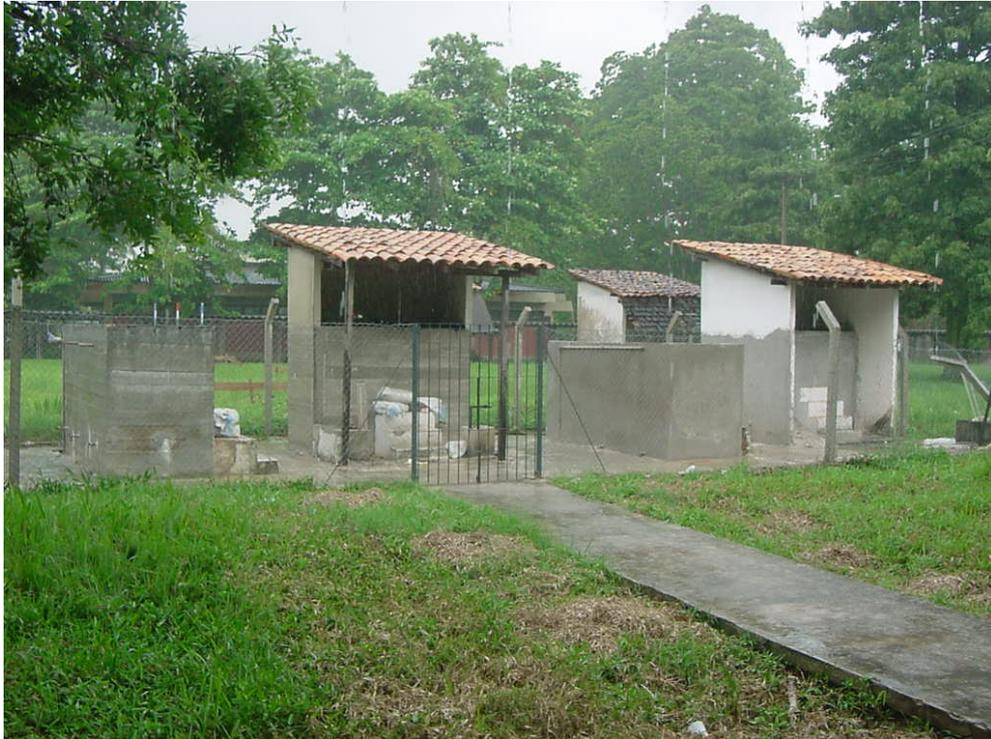
Fotografia 9 - Leitos de secagem cobertos e descobertos do sistema experimental da UFPA
