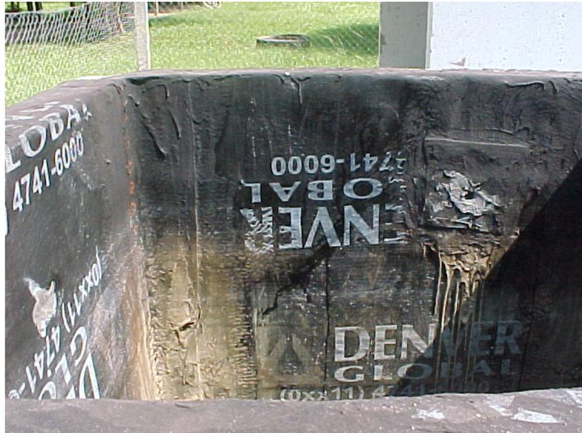
Fotografia 10 - Leito de secagem impermeabilizado com manta asfáltica
