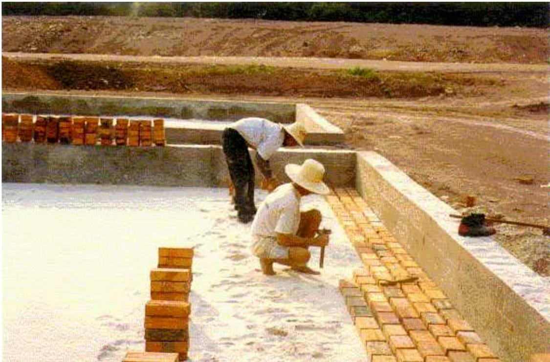
Fotografia 6 - Assentamento da camada suporte em leito de secagem no Aterro Sanitário do Aurá
