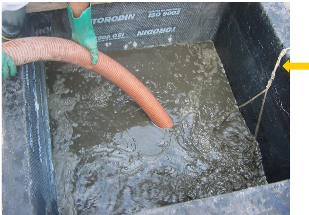
Fotografia 20 - Lançamento de lodo no leito de secagem descoberto
