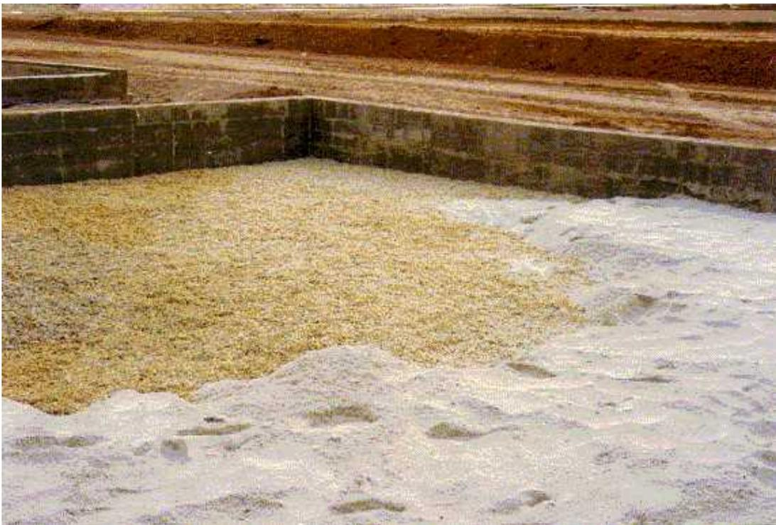
Fotografia 5 - Colocação da camada de areia em leito de secagem no Aterro Sanitário do Aura
